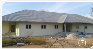
รูปที่ 12 : อาคารและสิ่งอำนวยความสะดวก ณ ศูนย์บรรเทาสาธารณภัย หน่วยบัญชาการทหารพัฒนา (1) อาคารที่พัก (2) อาคารสื่อสาร (3) อาคาร
