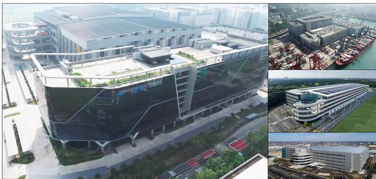
แผนภาพที่ 7 แนวคิดการพัฒนาศูนย์กระจายสินค้าท่าเรือกรุงเทพในลักษณะคลังสินค้าหลายชั้น
