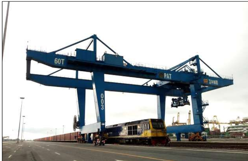
แผนภาพที่ 8 RMG ที่ติดตั้งในโครงการ SRTO ของท่าเรือแหลมฉบัง คร่อม 6 Rail Track
