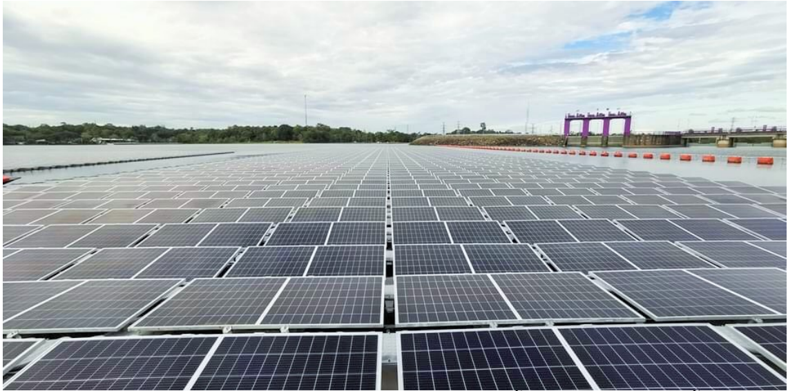
แผนภาพที่ ๒-๖ โรงไฟฟ้าพลังงานแสงอาทิตย์บนทุ่นลอยน้ำร่วมกับโรงไฟฟ้าพลังน้ำที่เขื่อนสิรินธร จังหวัดอุบลราชธานี (๑) (การไฟฟ้าฝ่ายผลิตแห่งประเทศไทย, ๒๕๖๔)
