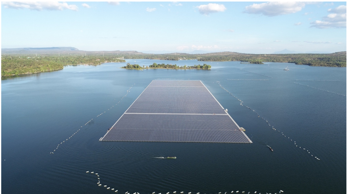
แผนภาพที่ ๒-๗ โรงไฟฟ้าพลังงานแสงอาทิตย์บนทุ่นลอยน้ำร่วมกับโรงไฟฟ้าพลังน้ำที่เขื่อนสิรินธร จังหวัดอุบลราชธานี (๒) (การไฟฟ้าฝ่ายผลิตแห่งประเทศไทย, ๒๕๖๔)
