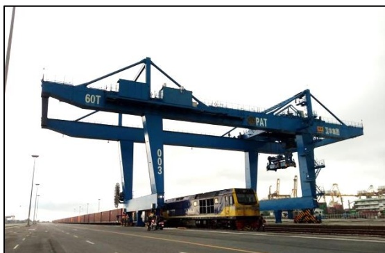
แผนภาพที่ ๙ RMG ที่ติดตั้งในโครงการ SRTO ของท่าเรือแหลมฉบัง คร่อม ๖ Rail Track
