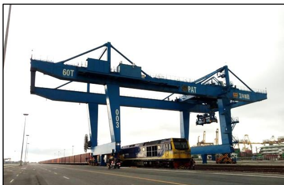
แผนภาพที่ ๙ RMG ที่ติดตั้งในโครงการ SRTO ของท่าเรือแหลมฉบัง คร่อม ๒ Rail Track
